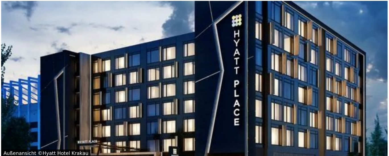
Außenansicht ©Hyatt Hotel Krakau
